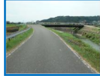
⑧船田の橋付近
