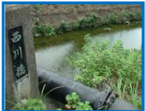
②西川橋付近
